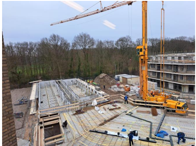
De wanden voor de begane grond zijn geplaatst
