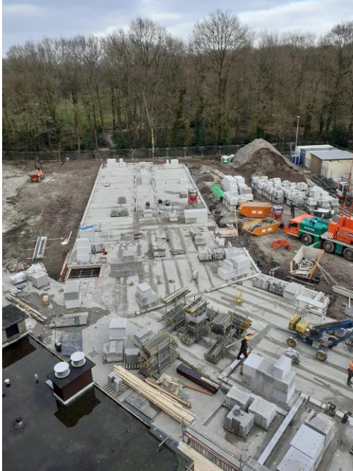
De vloer van de begane grond is gelegd
