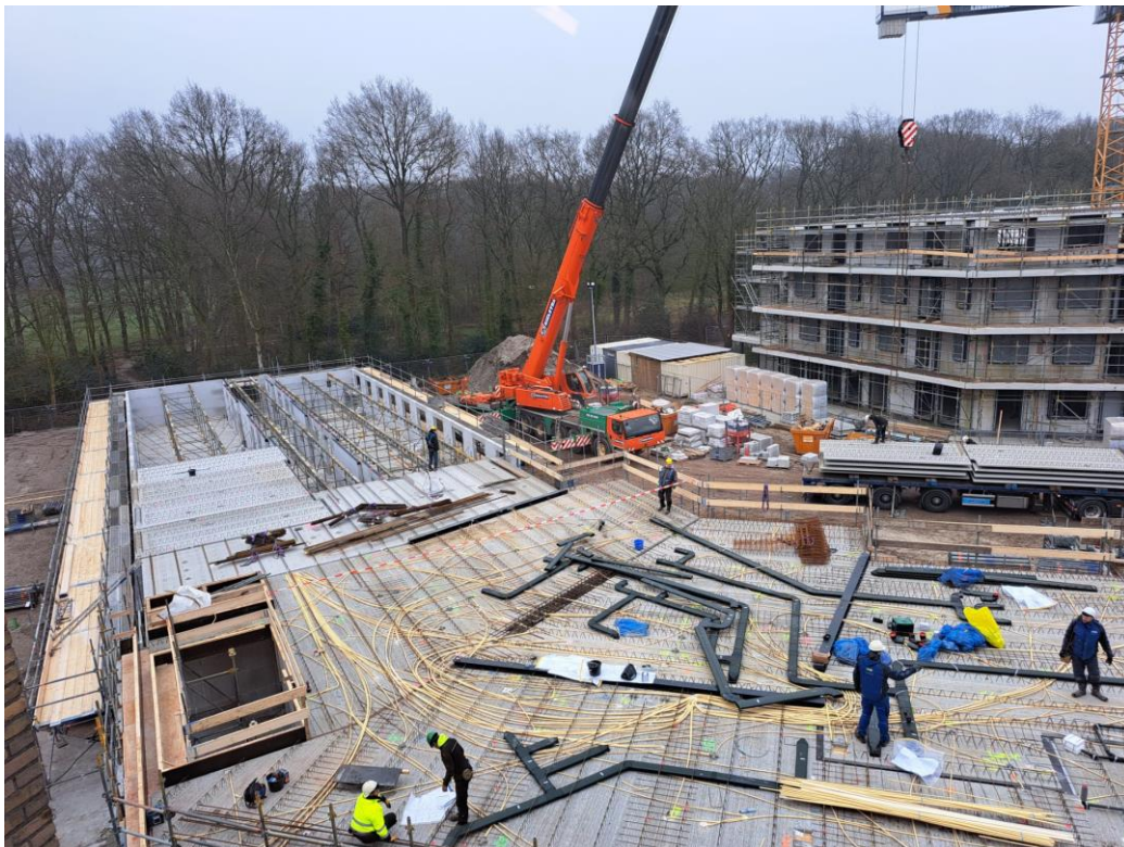
Het leggen van de eerste verdiepingsvloer is bijna klaar. Met dank aan Gerda Meints voor het maken van de foto's.
