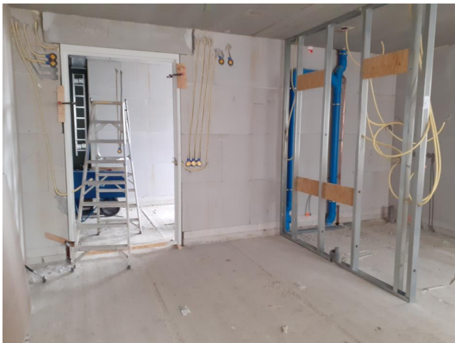
De contouren van het appartement worden zichtbaar: het stalen frame in de hoek wordt de badkamer. Op onderstaande foto is de voordeur te zien en een gedeelte van de badkamer.
